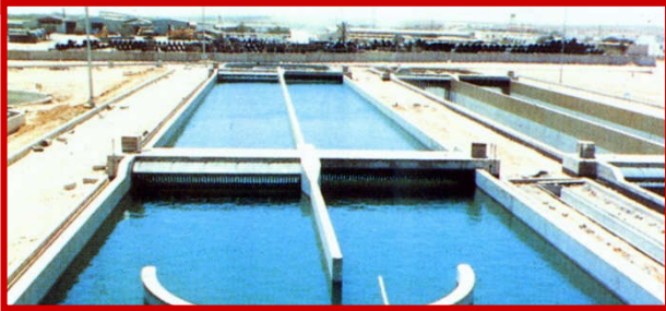
3. ระบบระบายน้ำและบำบัดน้ำเสีย เทศบาลเมืองปัตตานี (กรมโยธาธิการ)
