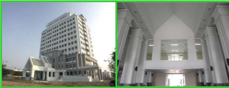
11. อาคารที่ทำการสำนักงานกรมสอบสวนคดีพิเศษและสถาบันนิติวิทยาศาสตร์ (กระทรวงยุติธรรม)
