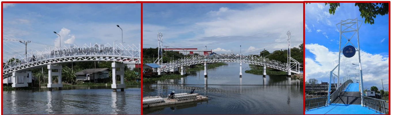
13. ออกแบบโครงการก่อสร้างสะพานข้ามคลองสำโรง (บริเวณวัดมงคลนิมิตร) (เทศบาลตำบลบางเสาธง)
