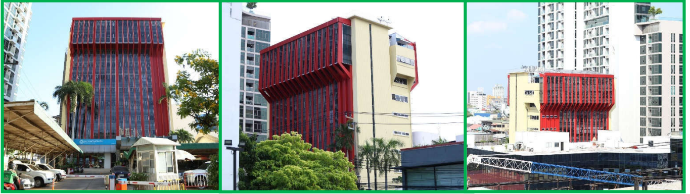
39. ปรับปรุงภายนอกอาคารธนาคารเกียรตินาคิน (บริษัท รวบรวมรณะ จำกัด)
