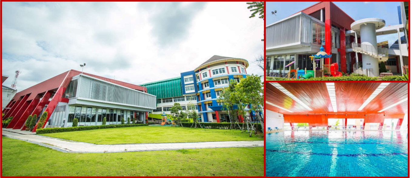
17. อาคารศูนย์สุขภาพเพื่อส่งเสริมสมรรถนะทางกาย ศูนย์นครนายก (มหาวิทยาลัยราชภัฏสวนดุสิต)
