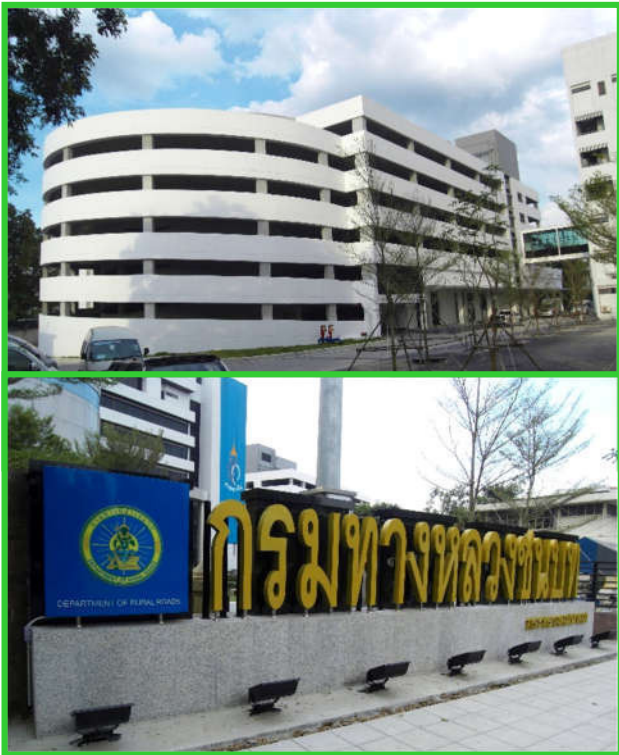
19. อาคารที่จอดรถสำนักงานใหญ่ (กรมทางหลวงชนบท)
