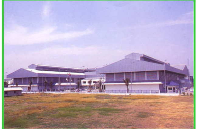
3. โรงงานฟอกหนัง (บริษัท เอกโค แทนเนอร์รี่ จำกัด)
