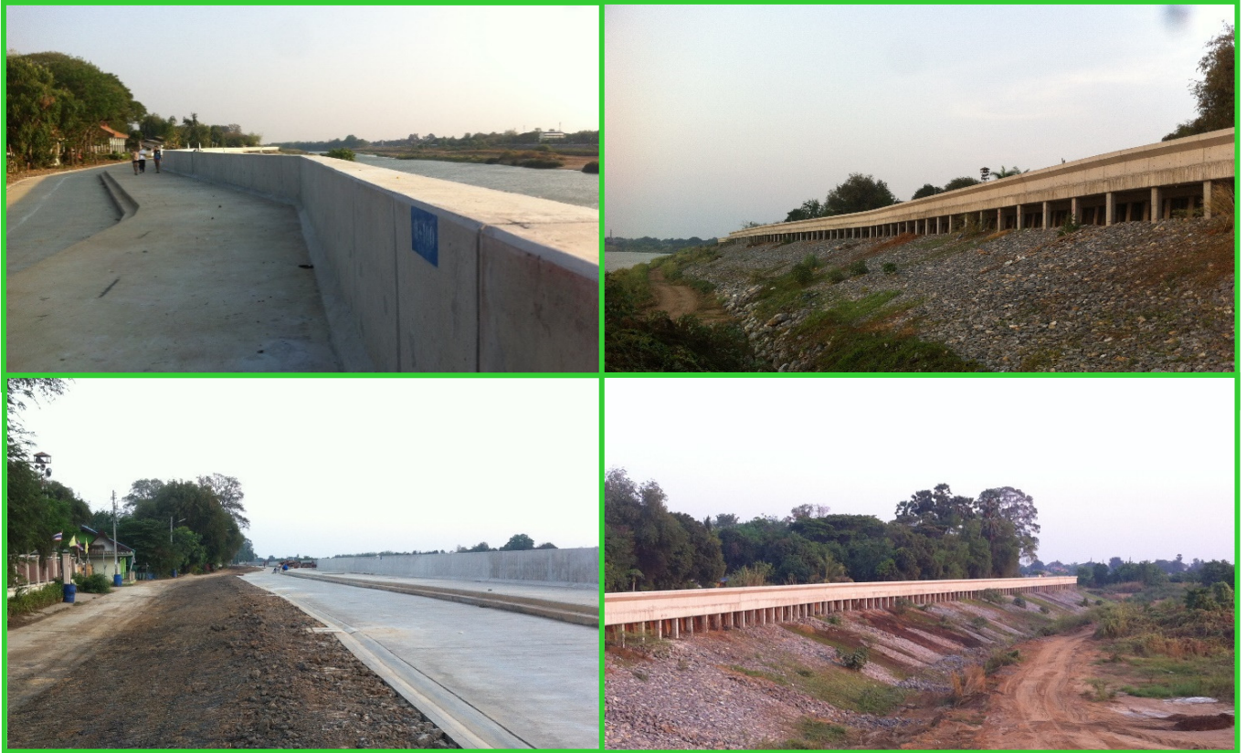
6. ระบบป้องกันน้ำท่วมชุมชนน้ำตาล ระยะที่ 1 (กรมโยธาธิการและผังเมือง)
