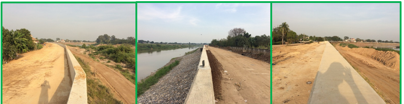
8. ระบบป้องกันน้ำท่วมชุมชนน้ำตาล ระยะที่ 2 (กรมโยธาธิการและผังเมือง)
