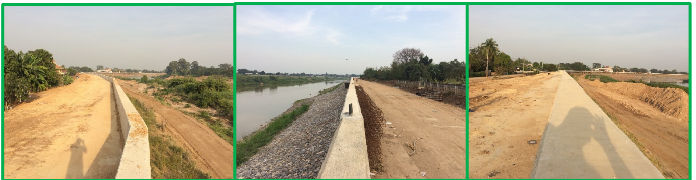
8. ระบบป้องกันน้ำท่วมชุมชนน้ำตล ระยะที่ 2 (กรมโยธาธิการและผังเมือง)
