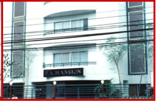
2. อาคารอพาร์ทเมนต์ 8 ชั้น (บริษัท โรงแรมสยามดินแดง จำกัด)
